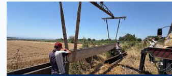
Kanalet Montajı
