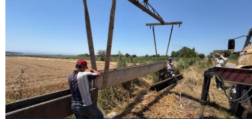
Kanalet Montajı
