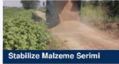
Stabilize Malzeme Serimi
