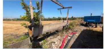
Kanalet Bakım-Onarım Çalışması
